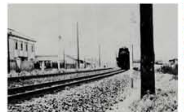
お栄の事故現場付近 (現在：清水保育園前)
