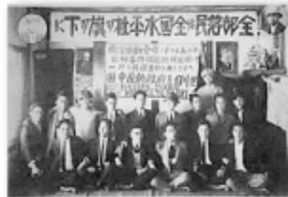
松園公会堂（室内にて）昭和3年
